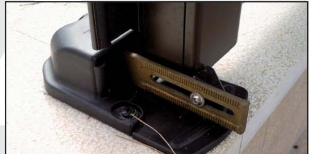
Detalle tope retenedor suelo
