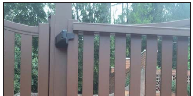
Detalle recepción corredera sobre pilar 125x125
