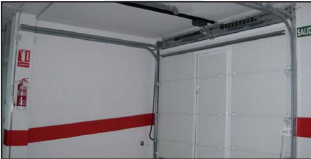
Seccional con peatonal insertada
