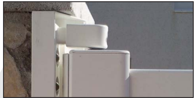
Detalle interior poste bisagra 80x30
